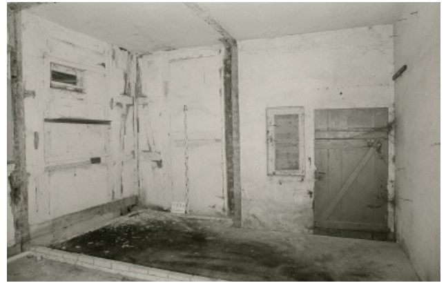
Abb. 8. Blick in großen Pflanzenzuchttraum. Er wurde insbesondere nach 1990 erheblich umgebaut. Die Rückwand (Südwand) hier mit Tür und Fenster stammen aus dem Umbau um 1875, Foto: K. Schmidt, 2013
