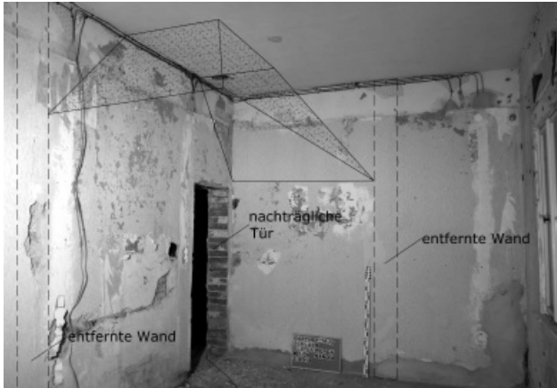
Abb. 7. Blick in die ehemalige Küche mit der Feuerstelle und einer Visualisierung des Rauchabzugs, Foto: K. Schmidt, 2013
