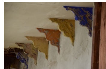
Abb. 6: Konsolen unter der Decke an der Nordwand
