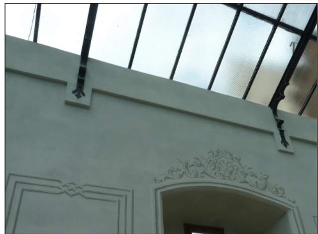
Abb. 4: Westliche Seite und Glasdach mit den Befestigungen der Dachkonstruktion
