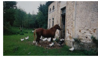
Abb. 9: Zustand der Orangerie um 1980
