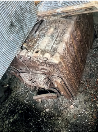
5 Serra Miramare, Kessel der ehemaligen Warmwasserheizung.
