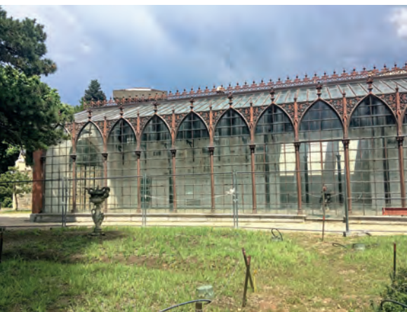
8 Glashaus Revoltella, Südfassade.
