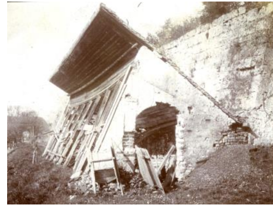
Zustand des Glashauses des ehemaligen Zisterzienserklosters Raitenhaslach um 1900, Foto Heimatpflegerarchiv Raitenhaslach, Wolfgang Hopfgartner.
