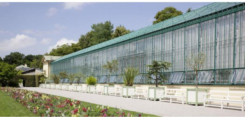
*Südsicht des Eisernen Hauses nach der Renovierung im Jahr 2014. Deutlich zu erkennen sind die ausgestellten Fensterflügel der Stehwandlüftung sowie die historischen Halterungen für eine Außenschattierung im Dachbereich. Foto: BSV, 2014.*
