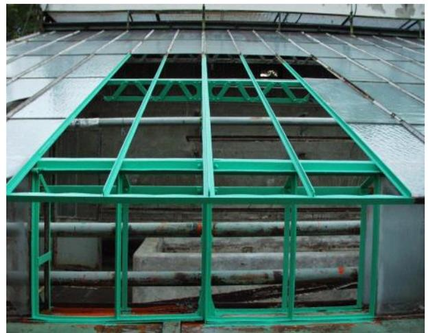
*Pilotrestaurierung am Warmhaus durch Georg Kolmanitsch: Abbau von Glaselementen, Strahlreinigung, zweifache Grundierung, zweifacher Deckanstrich. Foto: M. Stadlober, 1999.*
