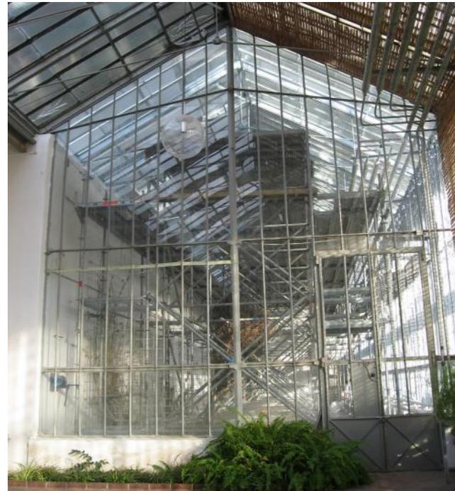
*Blick vom Mittelbau in den eingerüsteten Ostflügel während der Sanierung. Die Schattierung wurde durch ein unauffälliges helles Schattierungsgewebe ersetzt. Foto: R. Herzog, 2013.*
