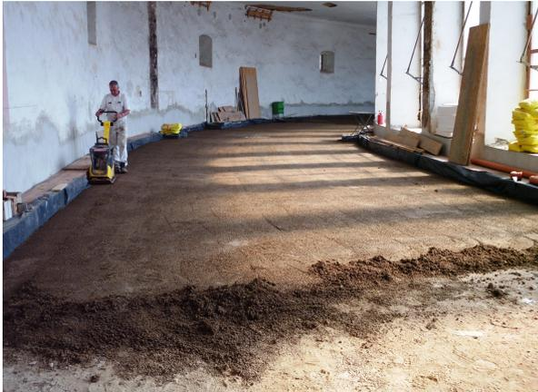
Einbau Stampflehboden Nordflügel, September 2012
